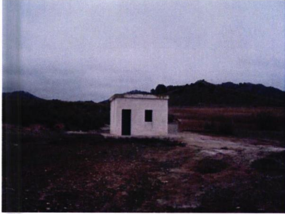
Foto 1. Pozo Nuevo de La Rapsa, Cúllar.
